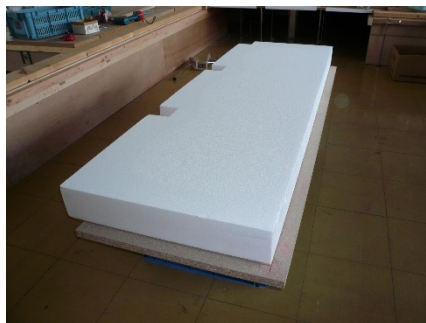
印に合わせて断熱材を置く。
