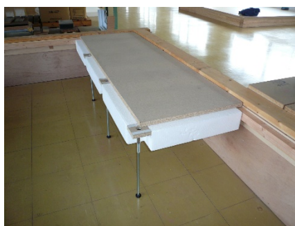
その後、パネルを敷設する。
